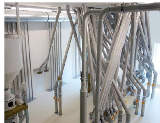
Für den Rohrbau entwickelte Daxner eine Kombination aus Sallhofer-Baukastensystem mit Edelstahlrohren
